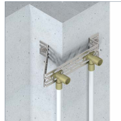
Крепление водорозеток при любом положении относительно несущего основания
